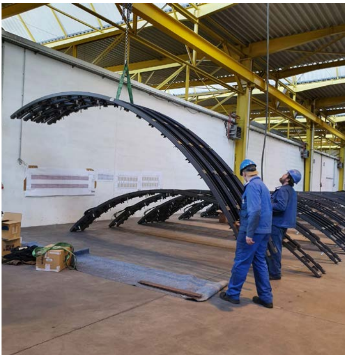
Abb.: Stahlbau, Deckenbau und die Installation der faseroptischen Komponenten mussten Hand in Hand gehen. Die Arbeiten wurden in unterschiedliche Teilbereiche gegliedert. Foto: Thomas Bruns
