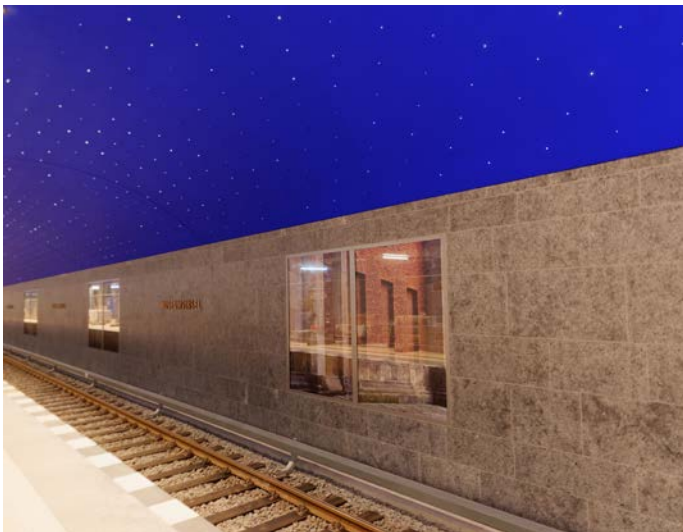
Abb.: Gestrichen wurde das Gewölbe mit einer blauen, schmutzabweisenden Spezialfarbe. Rund 130 Stück Fasern werden von jeweils nur einer LED-Lichtquelle versorgt. Foto: A. Reetz-Graudenz
